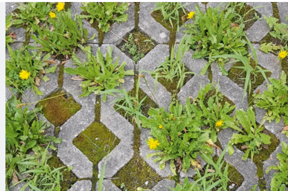
Voorbeeld van waterdoorlatende bestrating.
