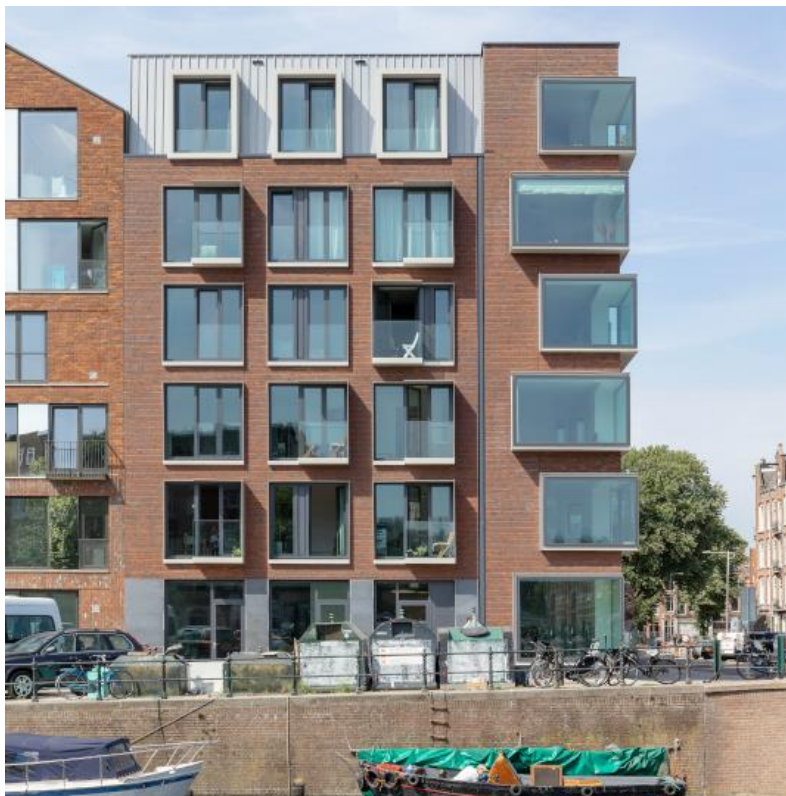
De Hallen Blok B5 – GAGAA, Gebouwdinamsterdam.nl
