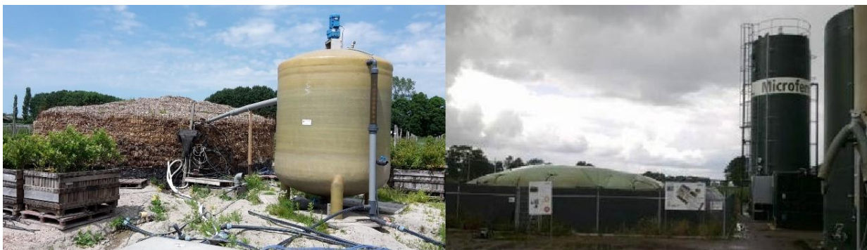
Figuur 3 De zeer kleinschalige biovergister op de Fruittuin van West (links) en een grootschalige mestvergister (rechts)
