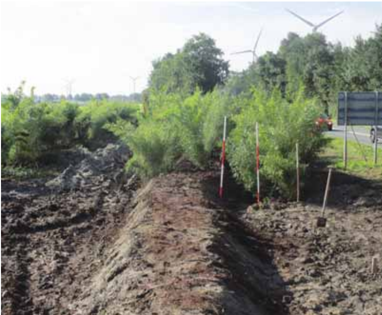
Bamboegeluidsscherm in aanleg
