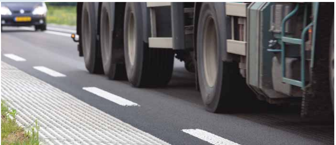
Whisstone: met diepe groeven uitgeruste betonnen elementen op gelijke hoogte met het wegoppervlak
