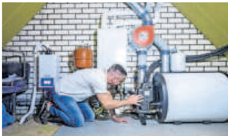
▲ Combinatie van een cv-installatie met een warmtepomp. Vanaf 2026 is een hybride pomp verplicht bij vervanging van de cv. FOTO: ANP
